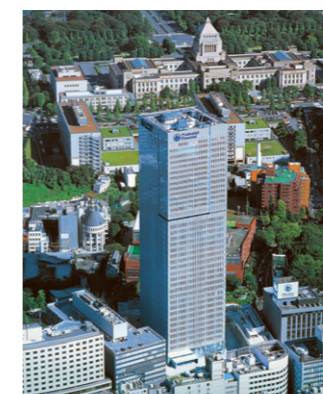
▲本社 プルデンシャルタワー (東京 永田町)
